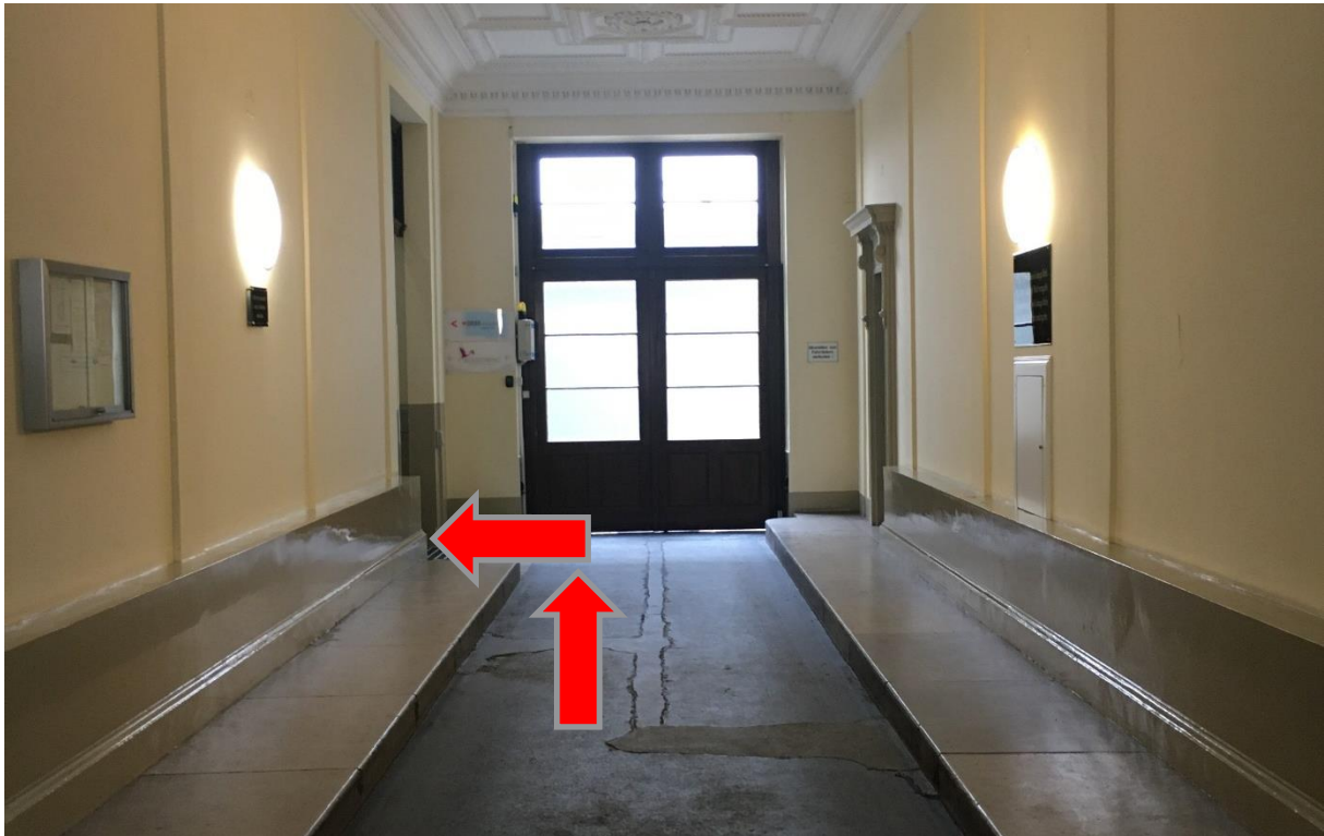
Abbildung 5 Eingangsbereich, der Pfeil zeigt den Haupteingang und Zugang zum Stiegenhaus mit barrierefreiem Lift in die Obergeschosse.
