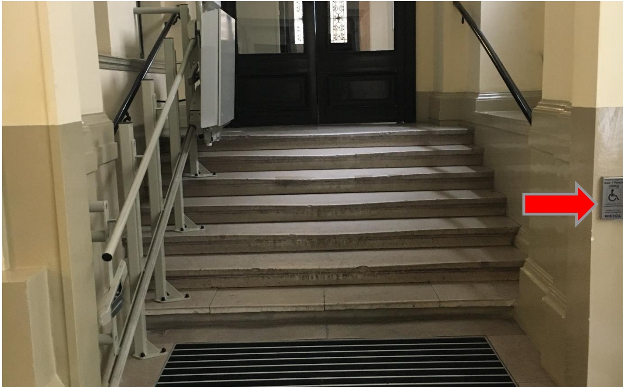
Abbildung 6 Eingangsbereich, Treppenlift links ins Hochparterre, Euro-Key auf der gegenüberliegenden Seite
