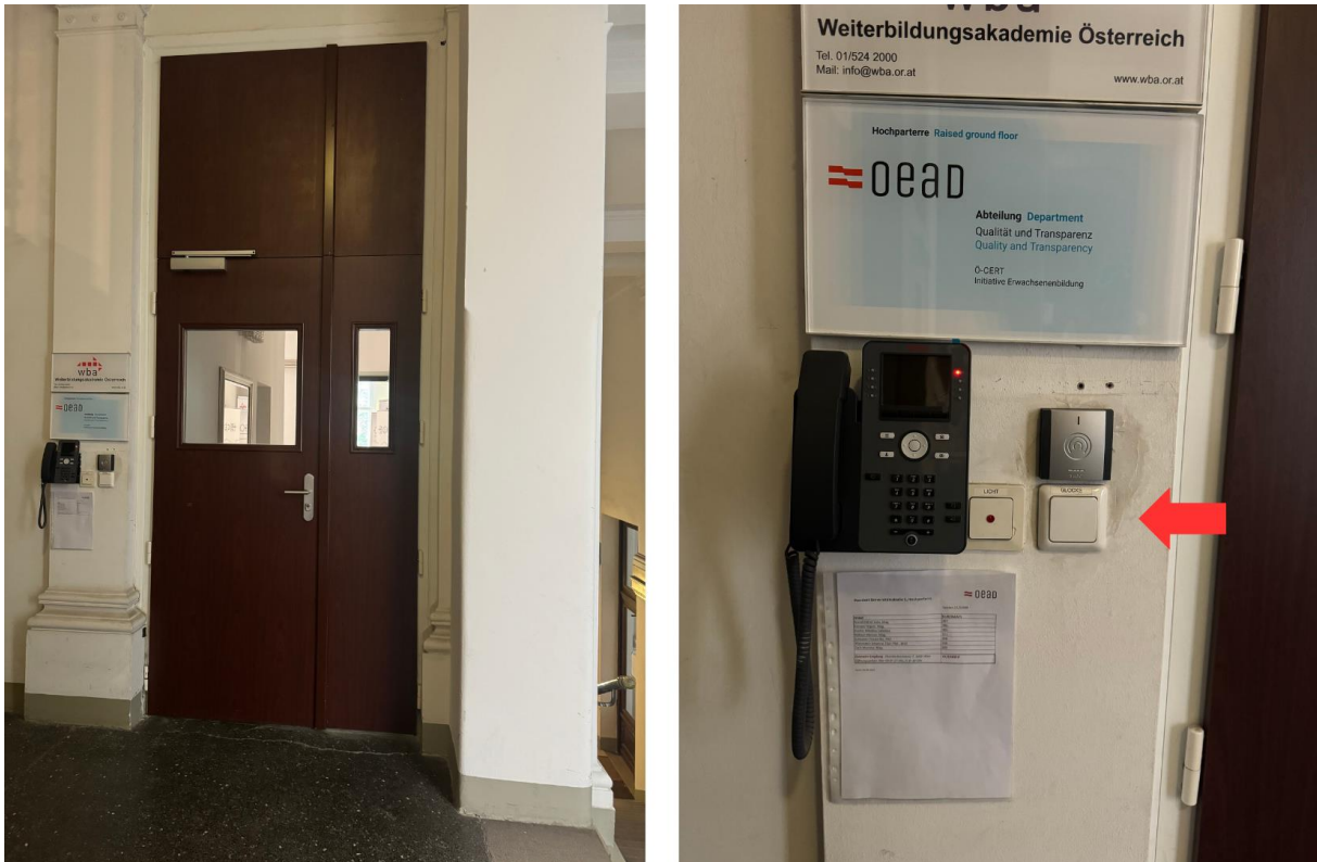
Abbildung 9: Drehflügeltüre und Glocke zur Galerie im Hochparterre
