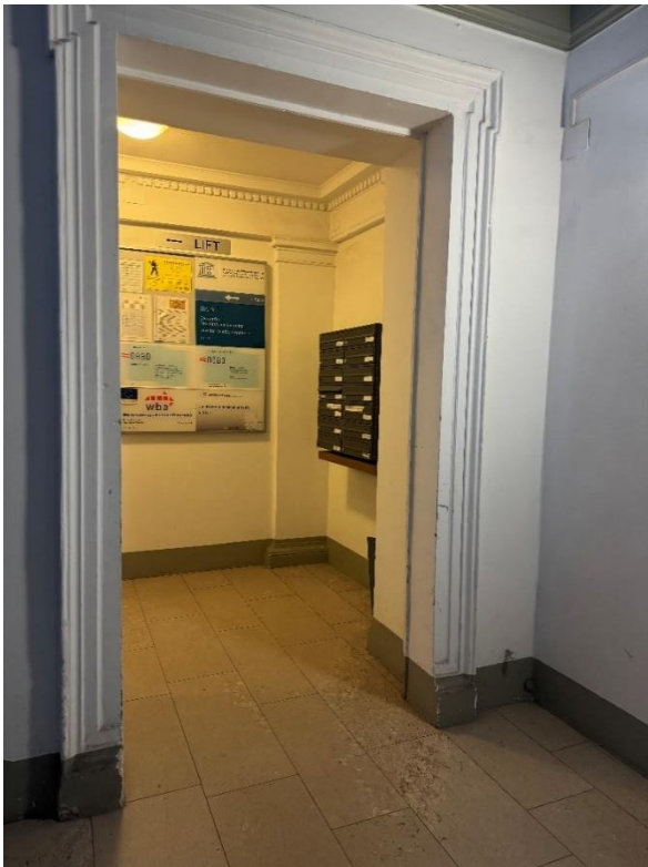
Abbildung 7: Verengung des Ganges am Weg zum Aufzug in der Universitätsstraße 5
