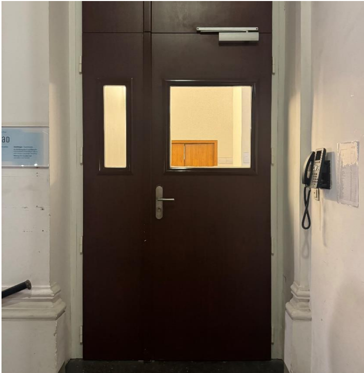
Abbildung 15: Drehflügeltüre zu Empfang und Bibliothek im ersten Obergeschoss
