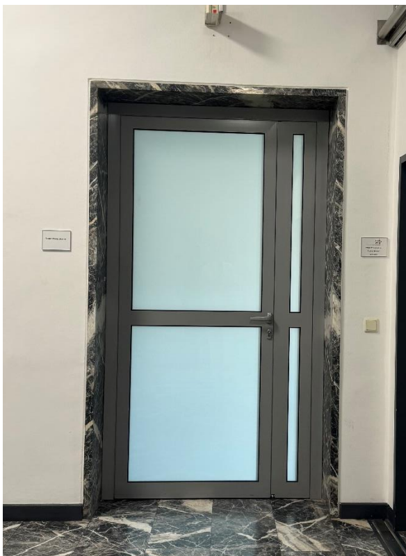
Abbildung 11: Drehflügeltüre zur Galerie, Hochparterre, Universitätsstraße 5
