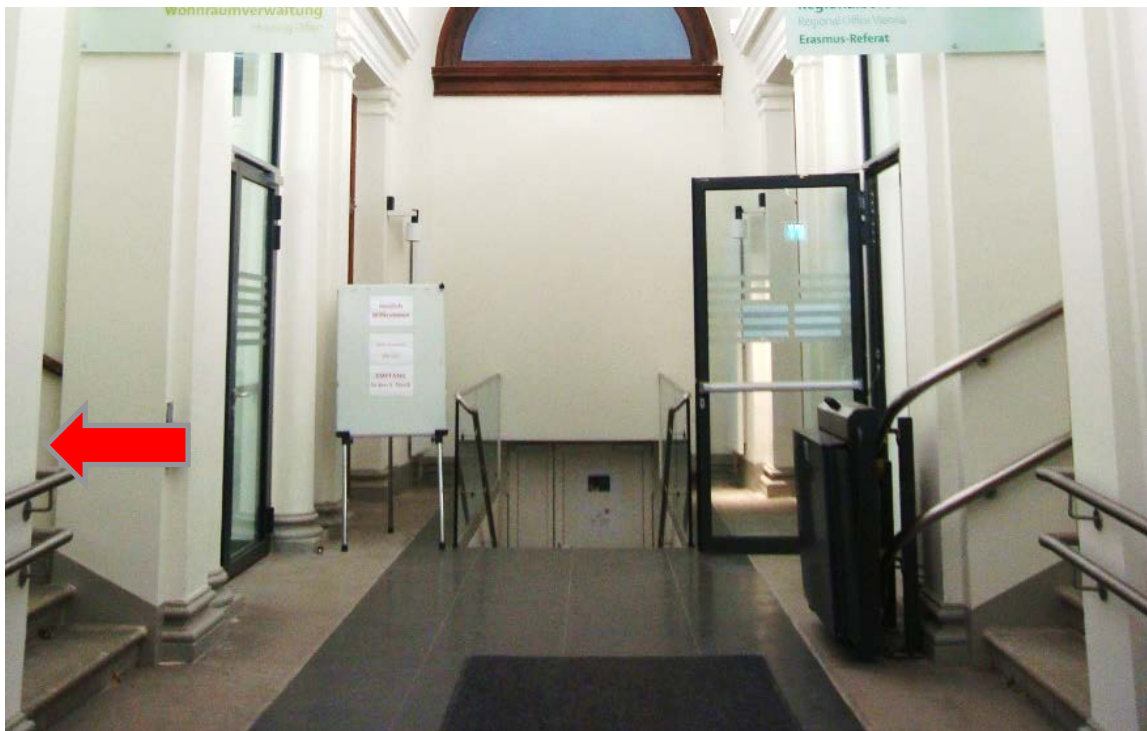
Abbildung 10 Eingangsbereich, Treppe zur OeAD-Wohnraumverwaltung - nicht barrierefrei
