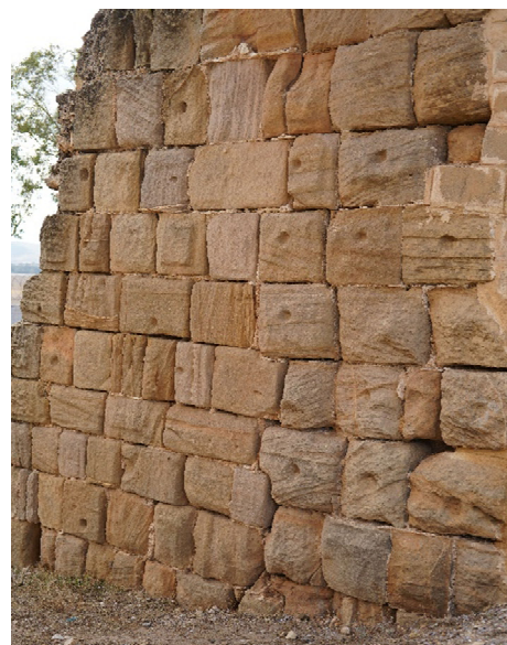
Fig. 5: marks of lifting tool ("Zangenlöcher")
